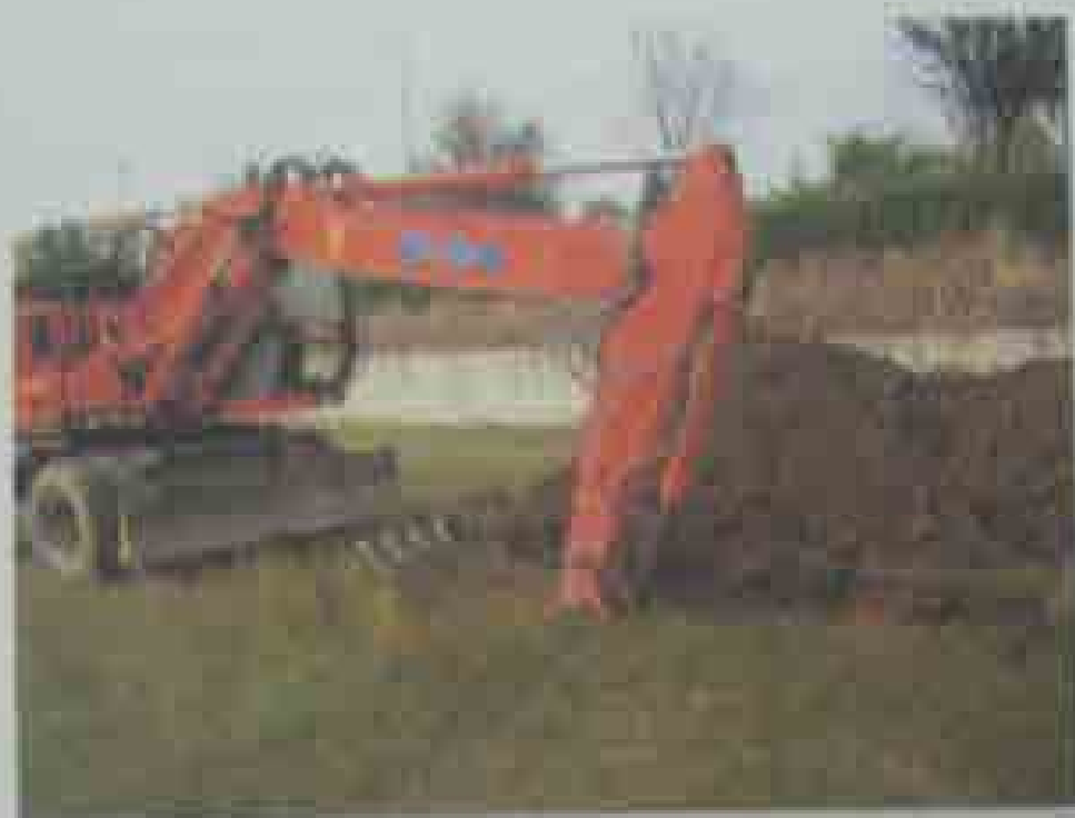
FOTO 3: Operazioni di scavo del pozzetto esplorativo P2
